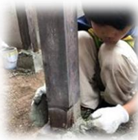
民家修繕DIY
